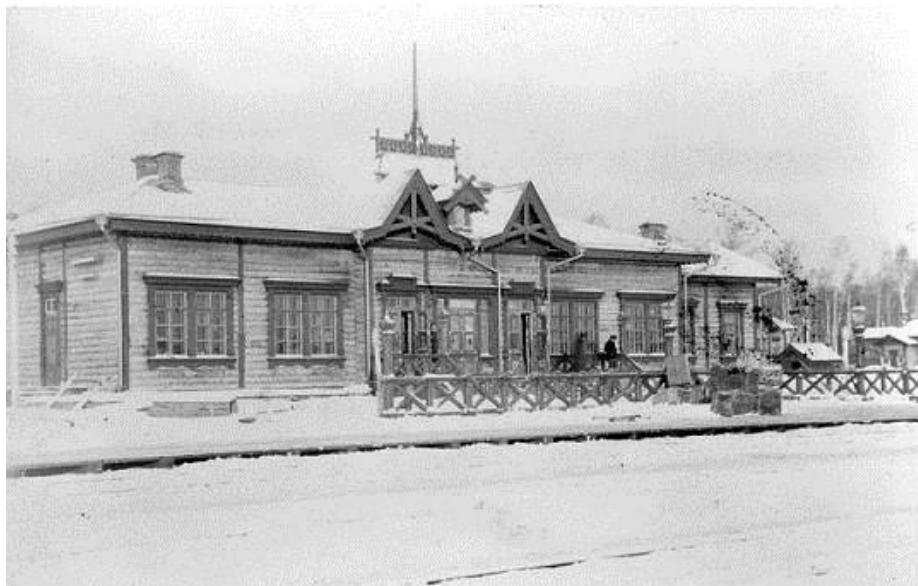
Первое пассажирское здание станции Тайга 1
